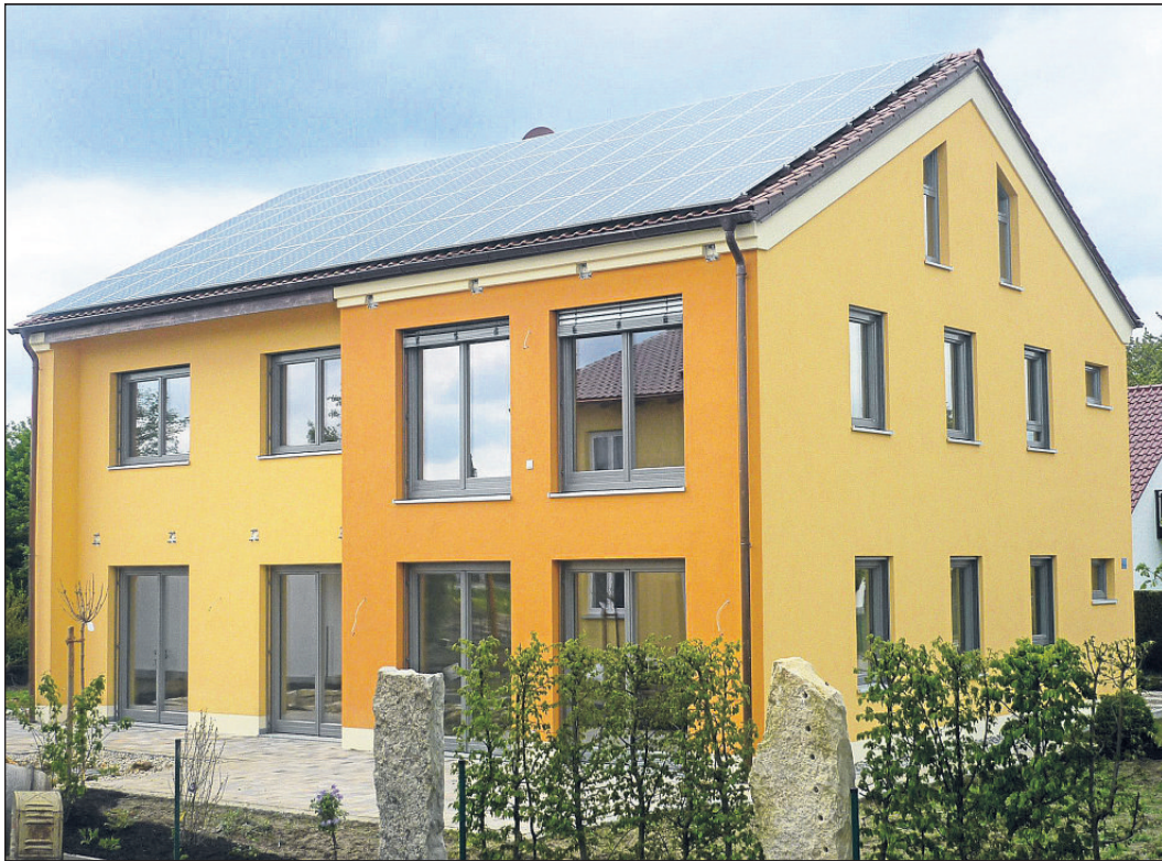
Das EnergieWertHaus verfügt als Energieüberschusshaus über modernste Technik, die weit über den aktuellen Standard hinausgeht. Fotos: oh
